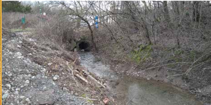
Busage sous voie ferrée Balastière
