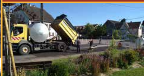
Travaux voirie rue de la Station
