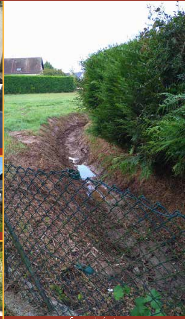
Curage des fossés
